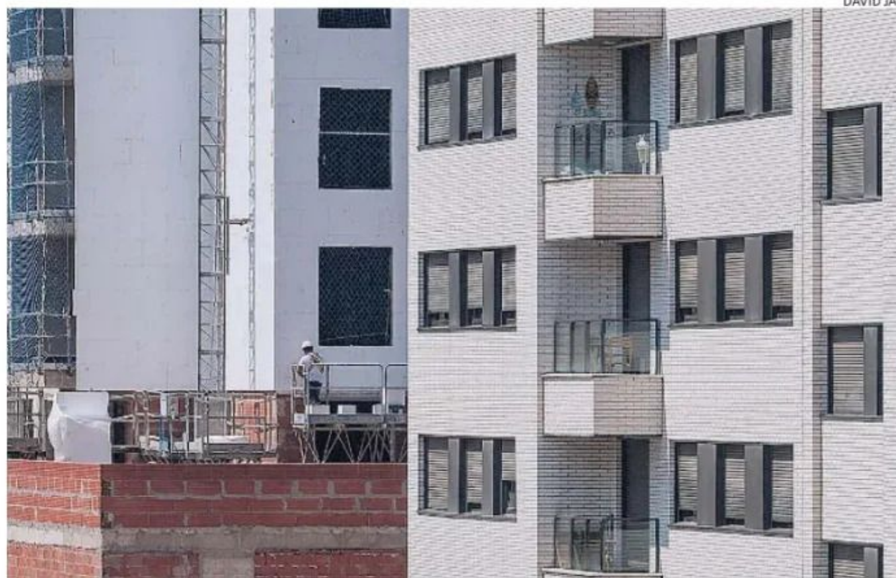
Construcción de nueva vivienda en el barrio de El Cañaveral
